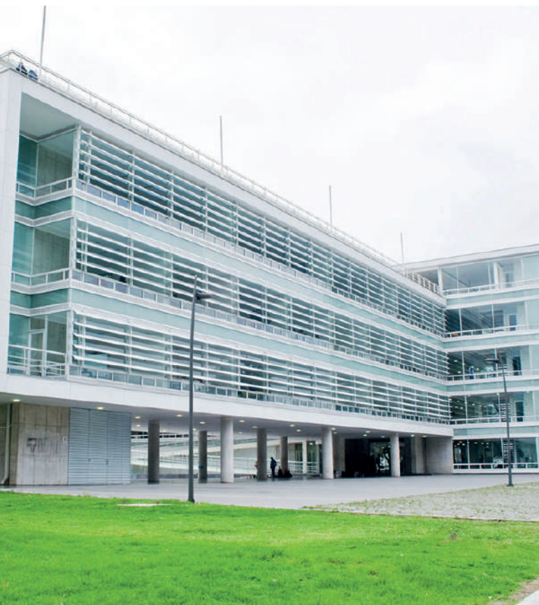
Edificio Ciencia y Tecnología
