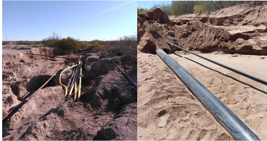
Figura 1: Ejemplo de erosiones en Flowlines y Ductos
