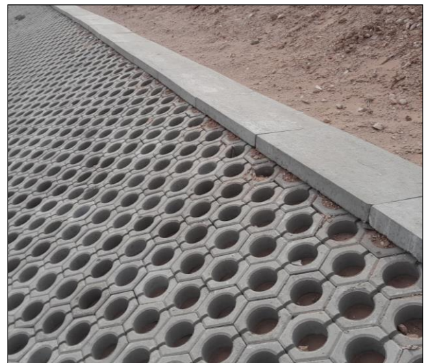
FIGURE 26: LOSETA DE CORONAMIENTO
