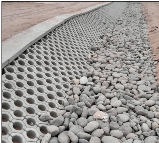
FIGURE 28: PROTECCION AL PIE CON ENROCADO
