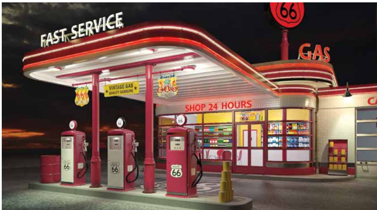
Figura 2. Estación de Servicio con expendio de alimentos.
