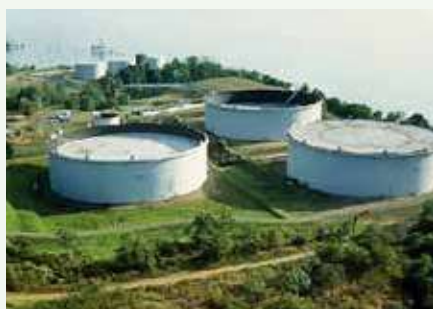
Tanques con membrana flotante
