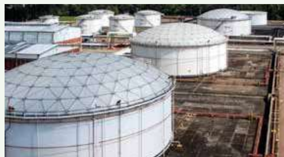
Tanque con Membrana flotante y techo geodésico
